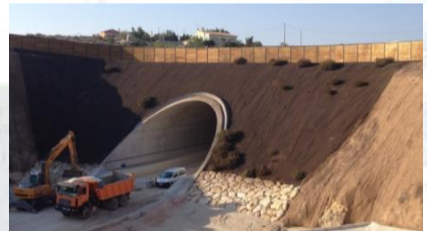
Emboquille de túnel con pie de escollera y sustrato para hidrosiembra
