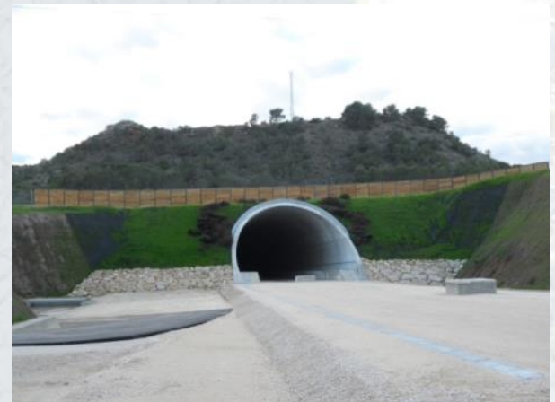
Trabajos de estabilización de emboquille de túnel
